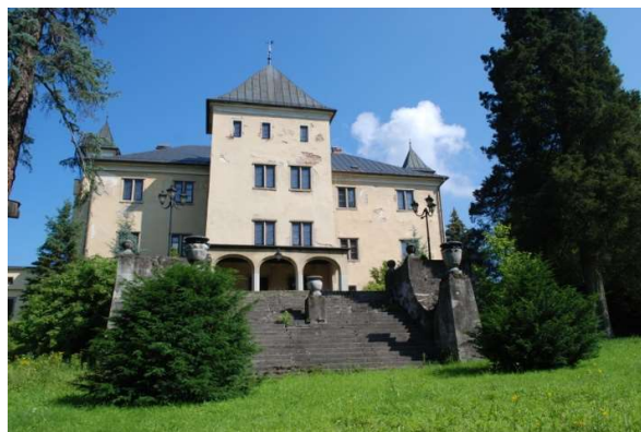
Elewacja ogrodowa, widok od południa
