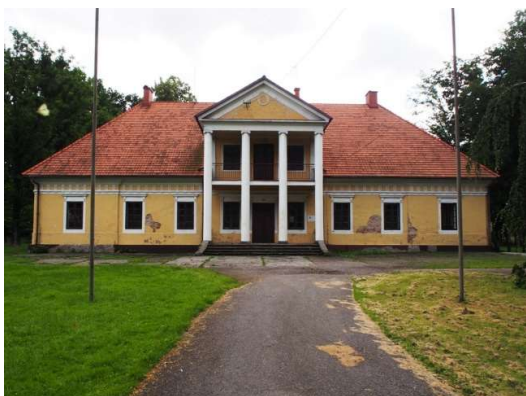
Frontowa, zachodnia elewacja dworu
