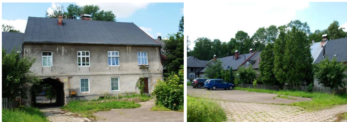
Budynek bramny z przylegającym od południa czworakiem, ul. Pałacowa 28
