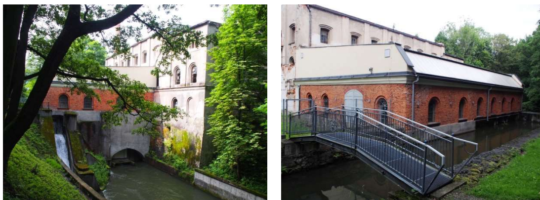
Widok budynku turbin od strony północnej i w kierunku NW
