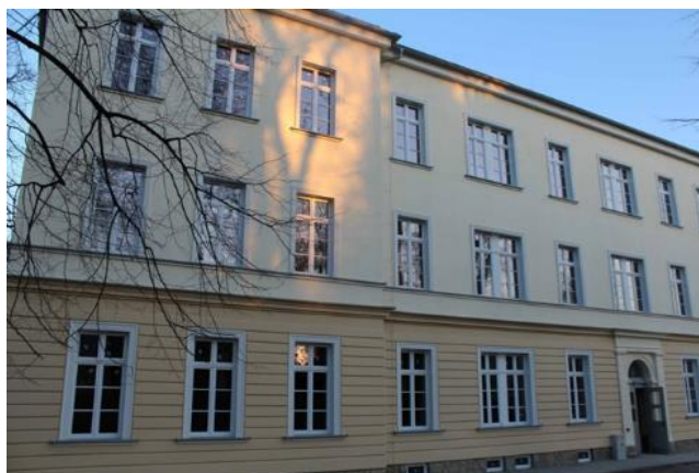
Rysunek 10 Wyremontowany Pawilon nr V Szpitala Pediatricznego w Bielsku-Białej, w którym realizowana jest działalność w zakresie psychiatrii dzieci i młodzieży
