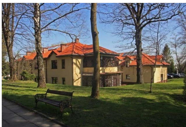
Rysunek 11 Pawilon Główny Bielskiego Centrum Psychiatrii – Olszówka w Bielsku-Białej, w którym funkcjonuje oddział całodobowy psychiatryczny z izbą przyjęć i poradnia zdrowia psychicznego
