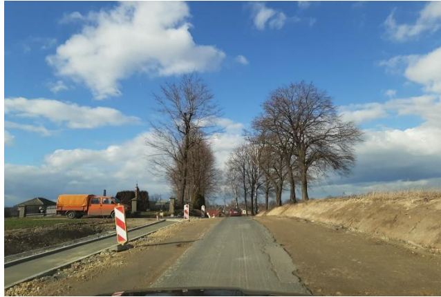
Rysunek 25 Przebudowa drogi powiatowej 4488S na odcinku 2622 m w Hecznarowicach – etap III
